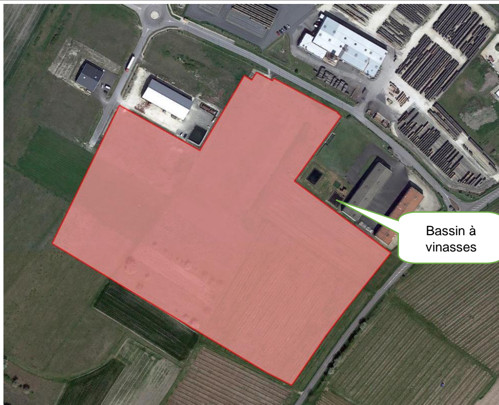
Figure 33 : Localisation du bassin à vinasses — Site CHARLEMAGNE MMI
